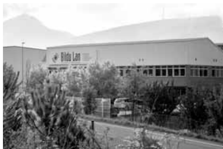
Exterior de la fábrica de Bildu Lan, en Torres de Elorz.
